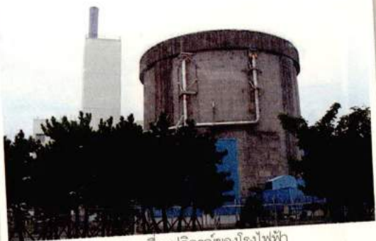
อาคารเครื่องปฏิกรณ์ของโรงไฟฟ้า
