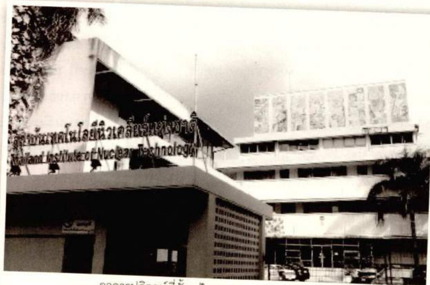
อาคารปฏิกรณ์ที่ตั้งอยู่ใน สทท. บางเขนในปัจจุบัน
