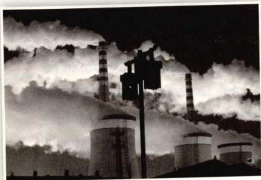
โรงงานผลิตกระแสไฟฟ้าถ่านหินของจีน
