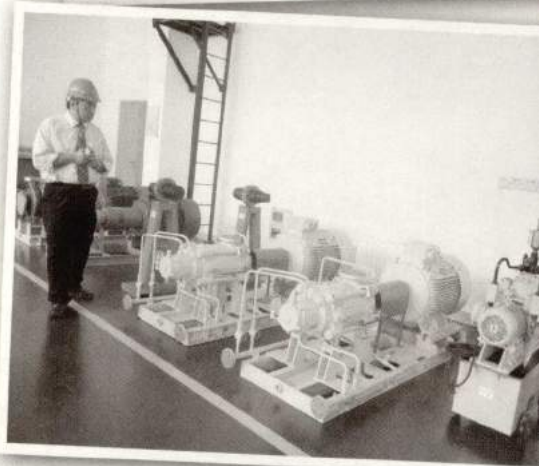
อุปกรณ์ต่างๆ ที่ติดตั้งอยู่ในโรงไฟฟ้านิวเคลียร์
