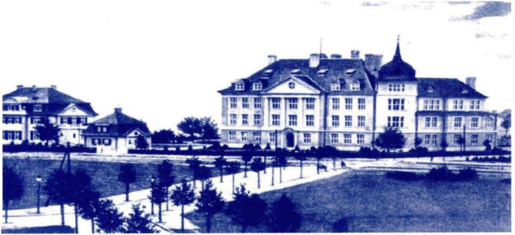
สถาบันเคมิเกเซอร์วิลเฮล์ม ปัจจุบันคือ “อาคารออตโทฮาน” ของมหาวิทยาลัย Freie Universität
