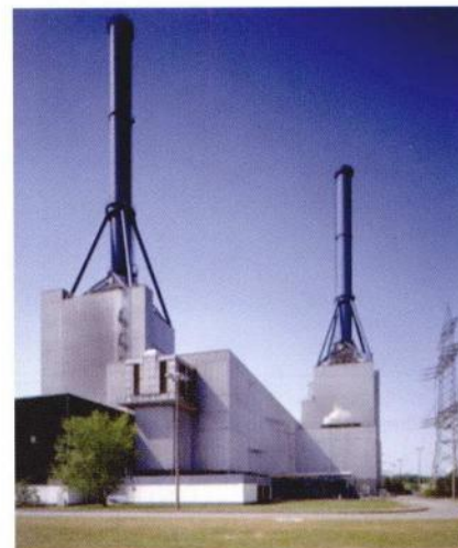
โรงไฟฟ้าพลังงานนิวเคลียร์ที่เมืองสิงเก็น (Lingao) เยอรมนี (ที่มา : www.fotosearch.com )
