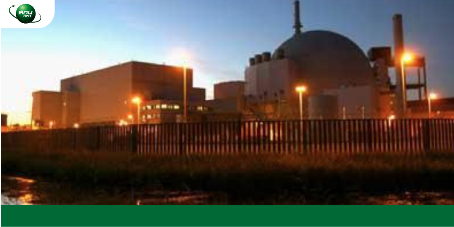
เรามองเห็นได้จากภาพโรงไฟฟ้านิวเคลียร์บรอกคดอร์ฟ (Brokdorf) ของเยอรมนี ผนังคอนกรีตมีบทบาทสำคัญในการเก็บกักมลพิษกัมมันตรังสี
