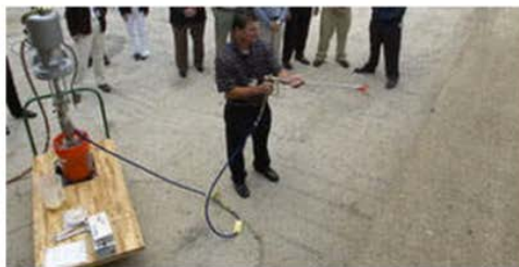
การฉีดพ่น Supergel บนพื้นผิวของคอนกรีตโดยใช้เครื่องมือ ที่หาได้ในท้องตลาด
